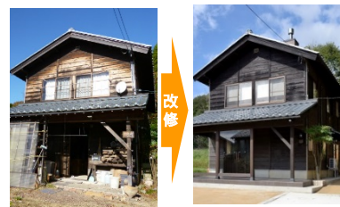
改修前 (空き家)
